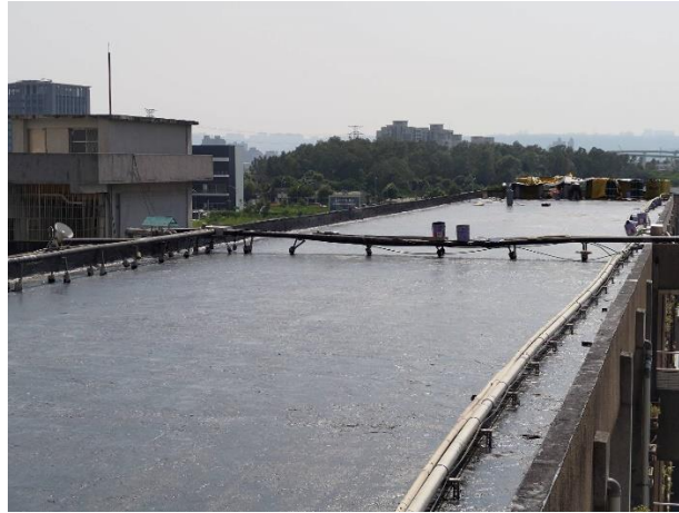
圖 1 整修工程現場圖(上底油、瀝青)
